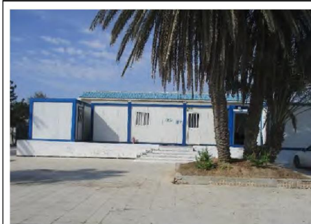
Bureaux de chantier
