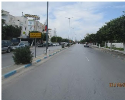
Signalisation routière au niveau de la route principale - accès au chantier
