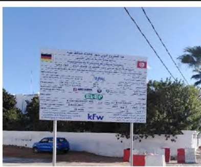
Panneau d'identification du chantier
