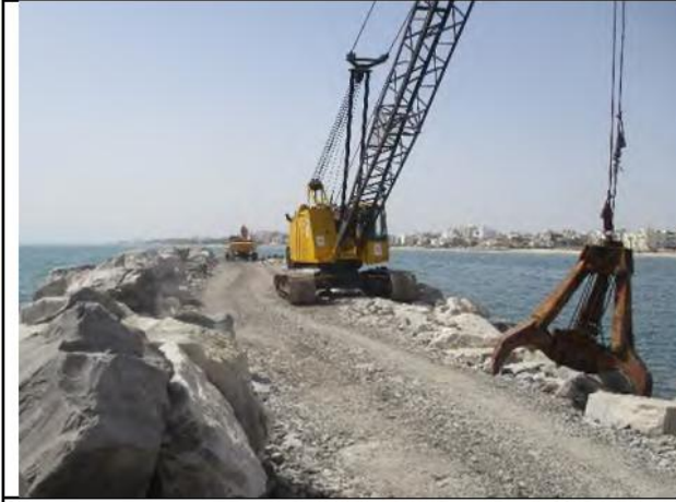
Matériel utilisé pour la mise à la côte du Brise-lames 4 (Grue LinK –Belt 25T & Pelle)
