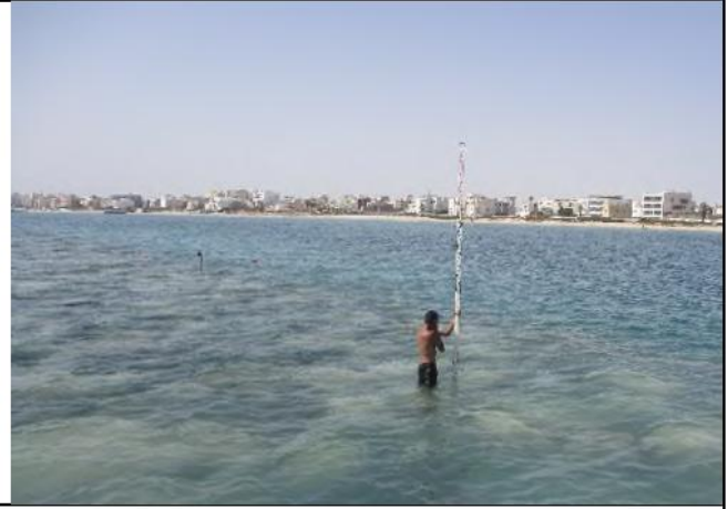
Réception topographique de la mise à la côte du Brise-lames 4
